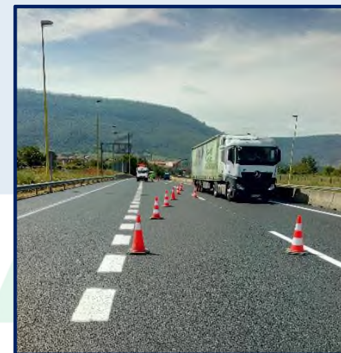
Imagen 1. Corte de carril para trabajos señalización horizontal de marcas viales
