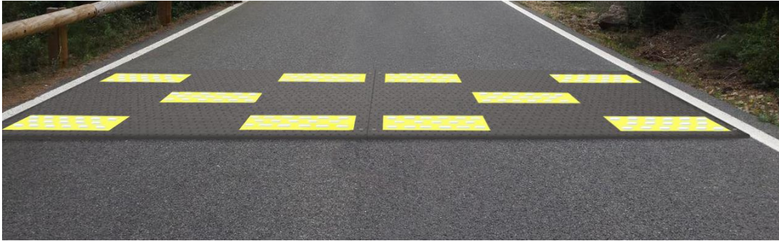
Puesta en obra del sistema de banda sonora portátil
