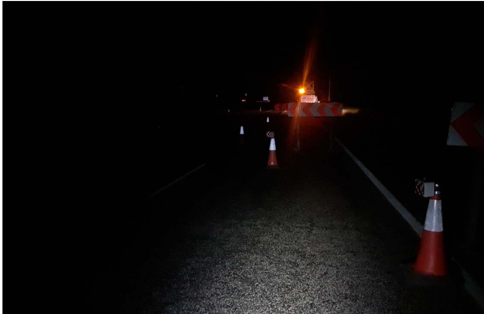
Foto en carretera con baliza LASER GUIA apagada
